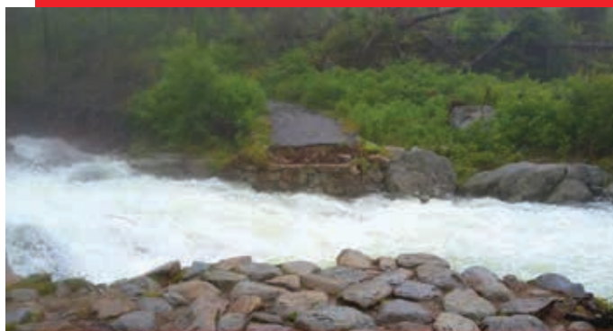
Prívalová voda po prietrži mračien strhla na turistickom chodníku most
