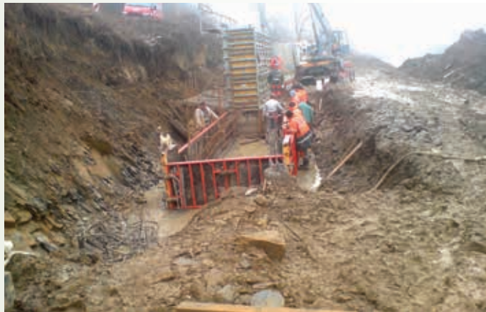
Oporný múr - sanácia zosuvu cestného telesa úseku cesty III54353 Lipany-Krivany
