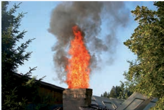
Požiar komínového telesa
